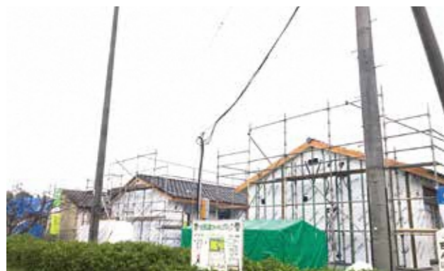
(仮称)球磨村大王原公園仮設団地(錦町)
