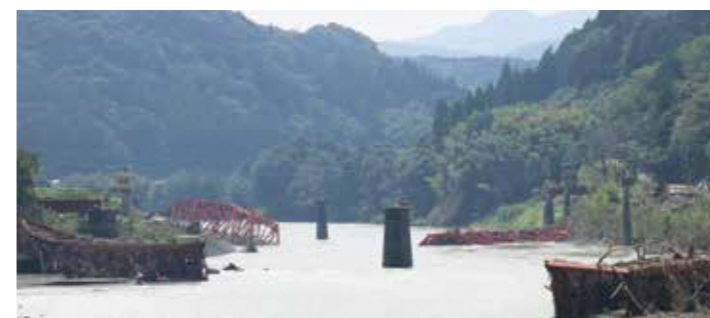
流失した相良橋と第二球磨川橋梁
