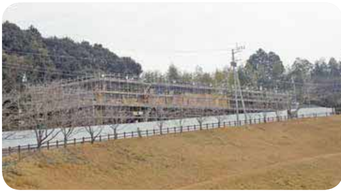
建設が進む渡災害公営住宅
