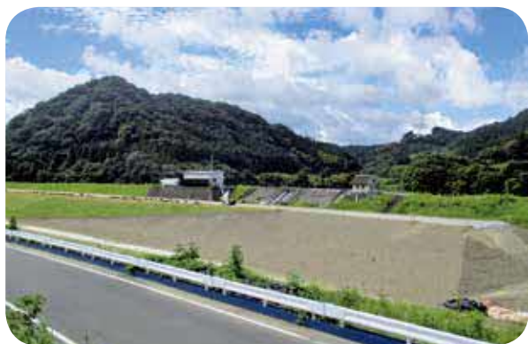
引堤の工事が進む茶屋地区
