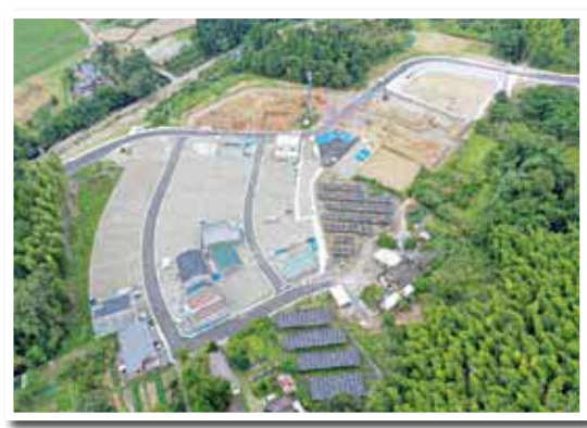
宅地整備が進む渡地区 塚の丸
