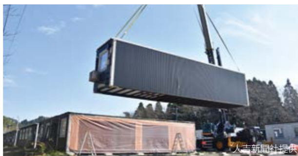
解体・撤去工事の様子
