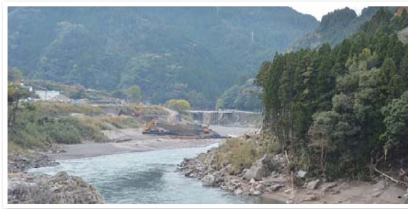
大瀬橋架け替え工事
