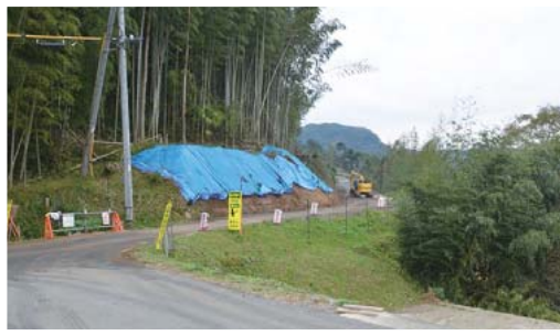
人吉大柿地区から球磨村への道路工事
