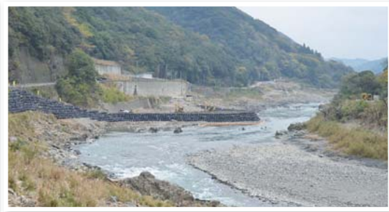
松本橋架け替え工事
