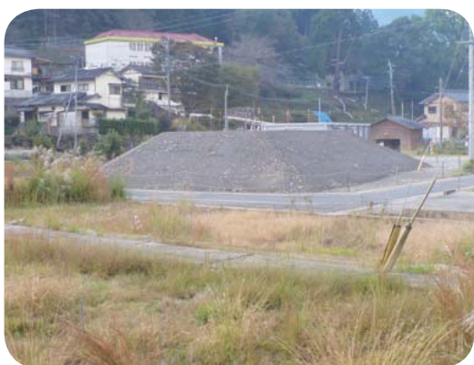
神瀬地区かさ上げ高先行箇所
