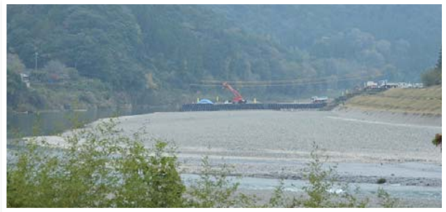
沖鶴橋架け替え工事
