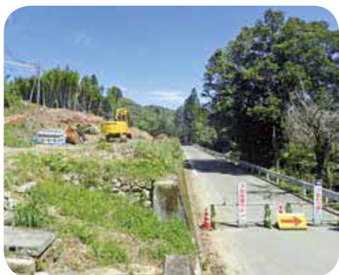
工事が始まった山口地区避難路整備
