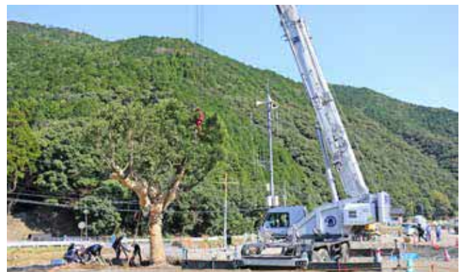
クレーンで吊り上げて移植しました
