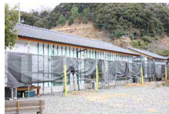
芝生広場木造仮設住宅整備の様子 (12月18日時点)
