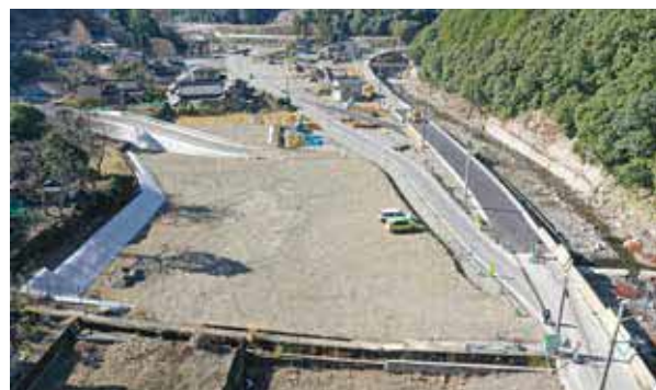
小規模改良住宅整備の様子 (12月18日時点)
