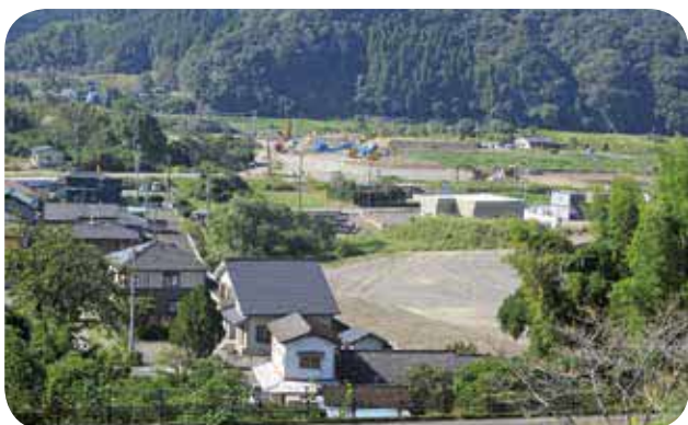
遊水地工事が始まった渡地域
