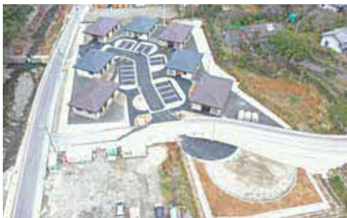
完成した神瀬団地
