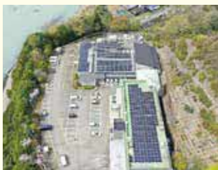
▲ 役場庁舎の太陽光発電設備
