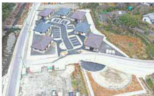
完成した神瀬団地
