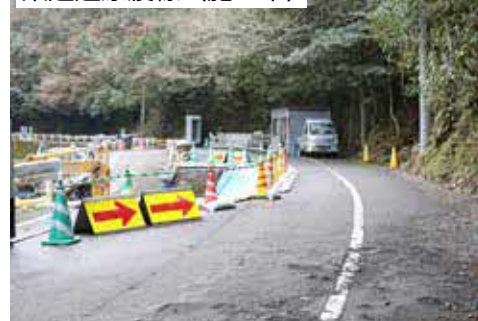
県道遠原渡線（施工中）
