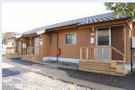
▲ 芝生広場木造仮設住宅
