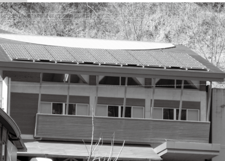
経費削減の目的で設置されたソーラーパネル（かわせみ本館）
