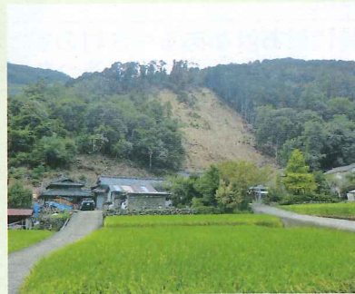
溝ノ上治山工事箇所
