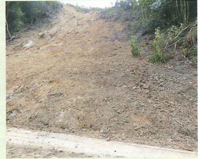
村道田代線災害復旧工事
