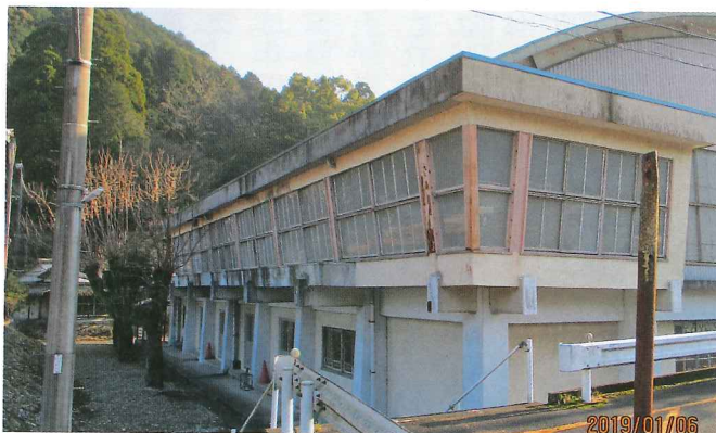
解体予定の旧神瀬小体育館
