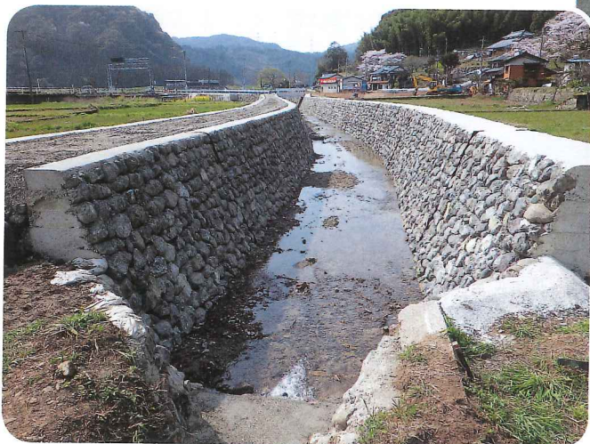
工事が進む峯川河川
