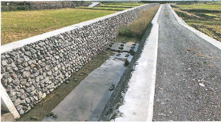
峯川河川整備工事
