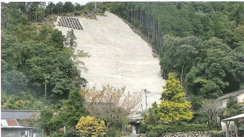
神瀬溝ノ上治山災害復旧工事
