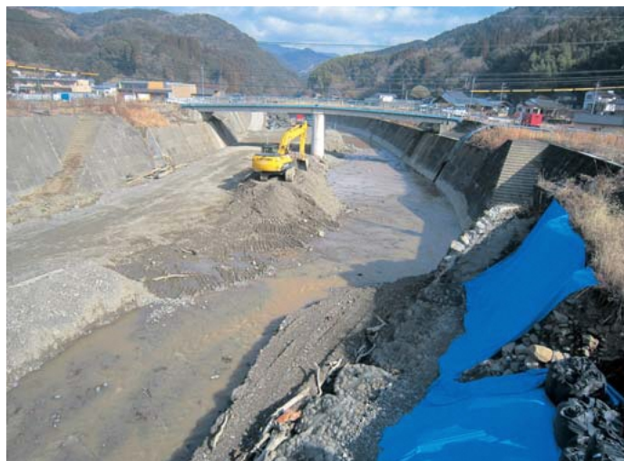
小川川掘削状況
