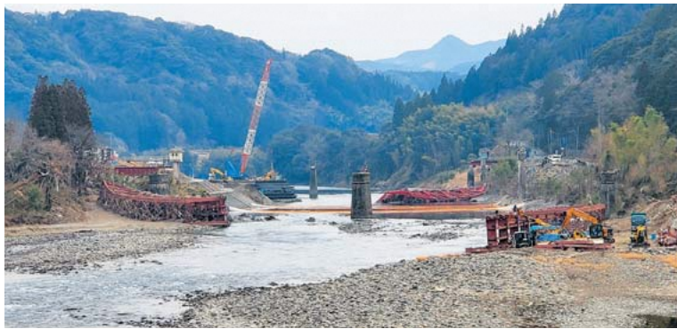
相良橋旧橋撤去工事
