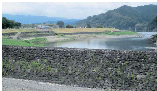
渡地区の導流堤と堤防
