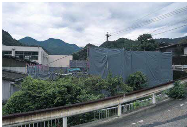
球磨中学校敷地内に建設される渡小学校仮設校舎
